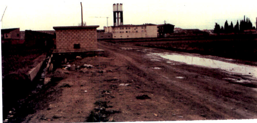
FOTO 1: Vista general de la captación de aguas subterráneas (en primer plano) y del depósito regulador.
